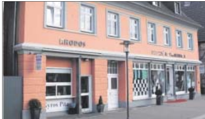
Ausgezeichnet: das Haus Massener Straße Nummer 22. (Stadt)
